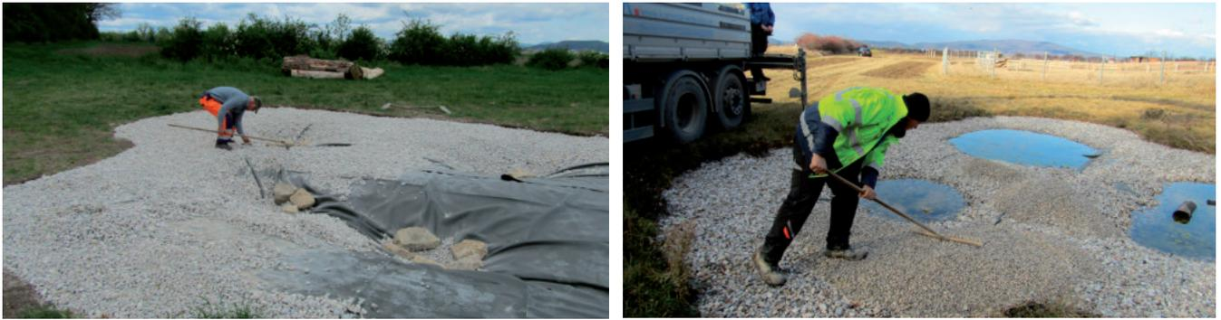
*Bau eines Teichs. Der Teich wird mit Teichfolie abgedichtet.*
