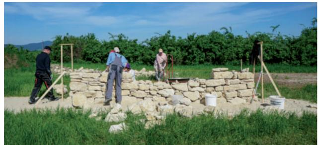
*Fundament und professioneller Aufbau einer Trockensteinmauer.*
