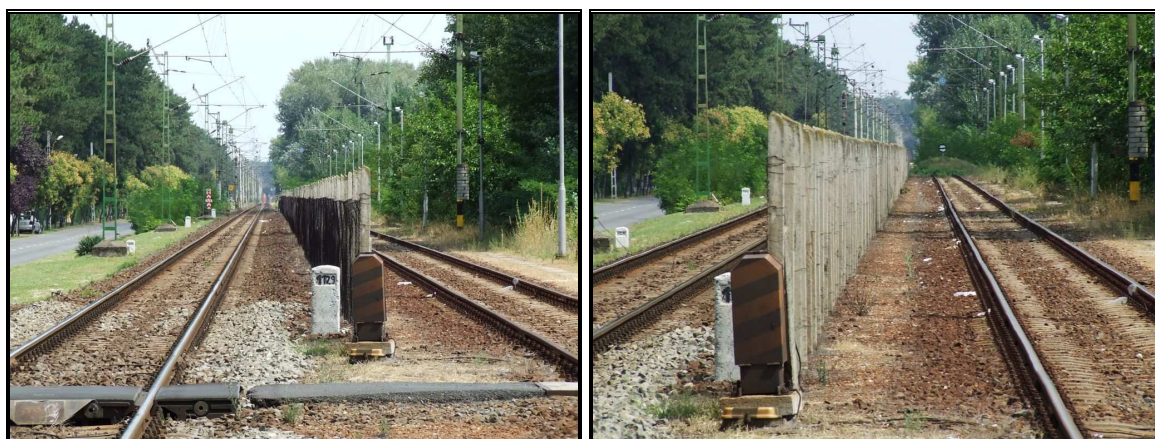
19. ábra: Siófok felől Balatonszabadi felé nézve látható, hogyan folytatható a második vágány. Egy térköznyi hosszban gyakorlatilag meg is épült, most kihúzó és földkúpban végződik (fotó: Weinreich Zoltán)
