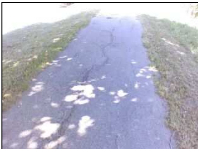
5. ábra: Kerékpárút burkolathibái Siófokon (fotó: Csüllög Imre)
