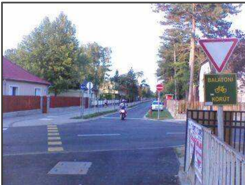
3. ábra: Siófok belterületén a járdán vezetett kerékpárút sok zavart keltő és előnytelen megoldás (fotó: Csüllög Imre)
