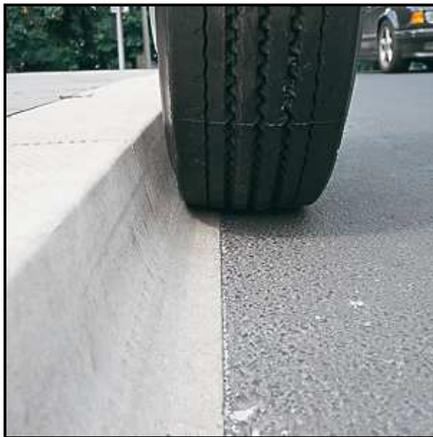
12. ábra: Praktikus profil akadálymentes buszmegálló kiképzésénél. (Forrás: http://www.lithonplus-steinmanufaktur.de/uploads/pics/Kasseler_Sonderbord.jpg )
