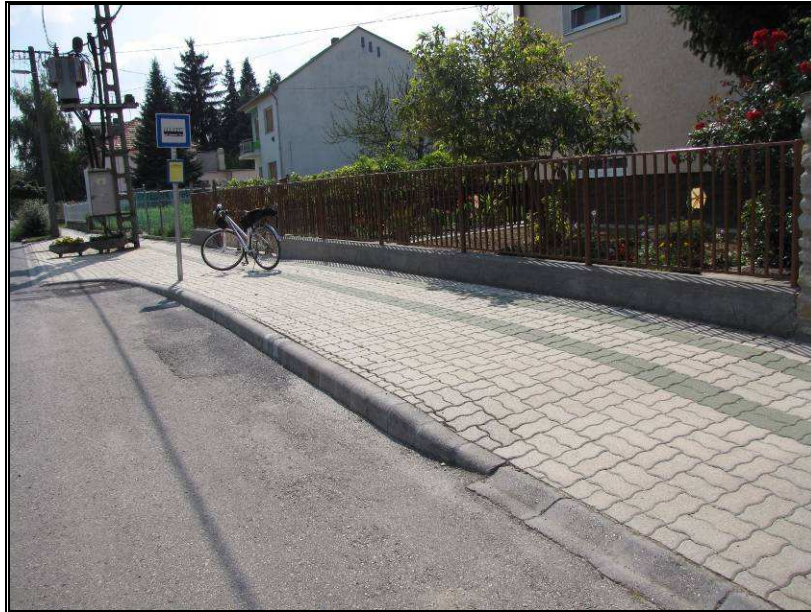
9. ábra: Megfelelően elkészített járdasüllyesztés Hévízen a Zrínyi Miklós utca 71. előtt. Akadálymentesítési feladat az információk elérhetőségének biztosítása a menetrendi tábla átalakításával, a kerékpársáv figyelmeztető szegélyezése vakok és gyengénlátók számára is érzékelhetően, valamint a megálló jelzése a járdán teljes szélességében vezetett taktilis sávval. (Fotó: Fehér Kata)
