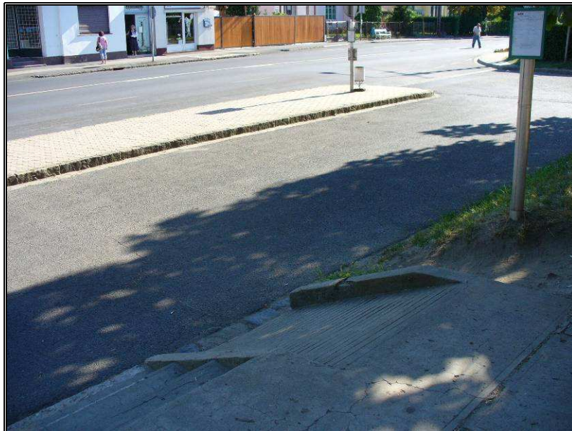
11. ábra: Balatonboglári autóbusz megálló. A kialakított rámpa meredeksége miatt nem használható, amit jól mutat a mellette szükségszerűségből kitaposott ösvény. A menetrendi tábla a várakozóhelytől távol található, megvilágítása nincsen. A szigetszerű peron sem közelíthető meg akadálymentesen. (Fotó: Gerőházi Éva)
