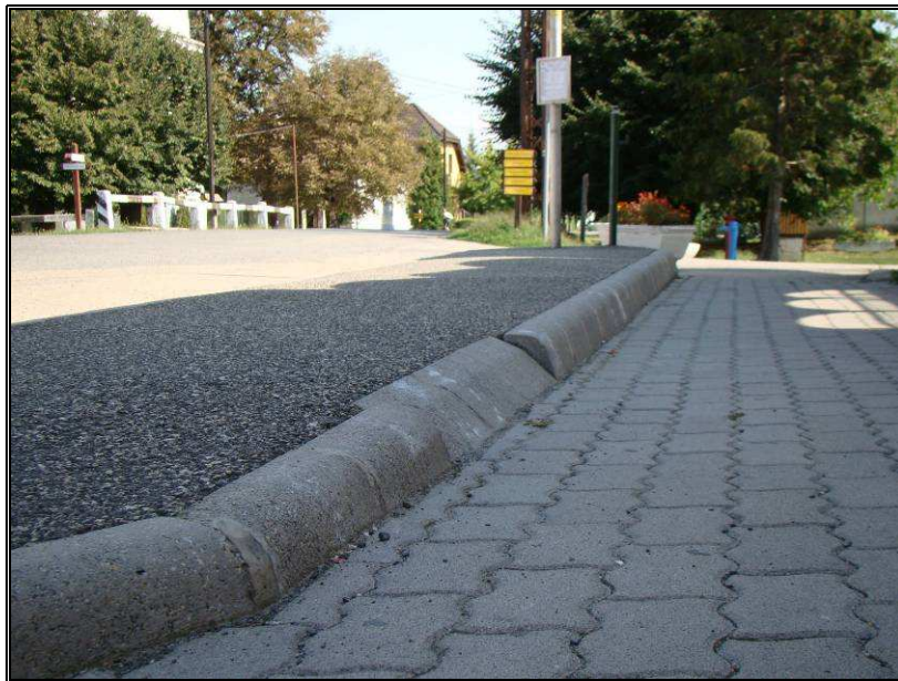
8. ábra: A kis magasságkülönbség ellenére a peron kerekesszékekkel nem közelíthető meg: a rámpa maximális meredeksége 8% lehet. (Fotó: Ekés András)
