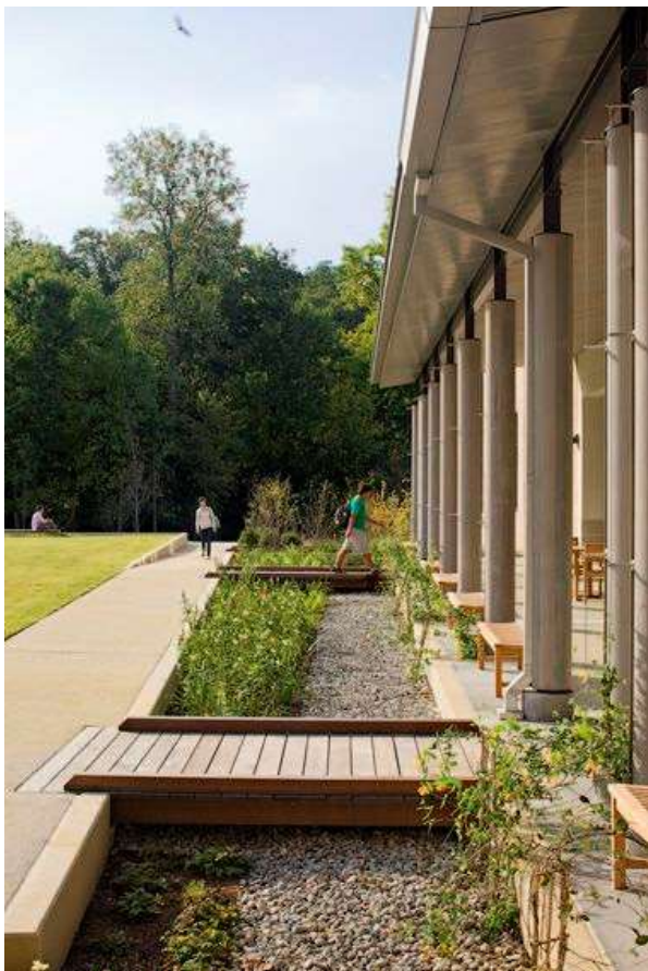
Süllyesztett zöldsáv esőkertként is megállja a helyét
