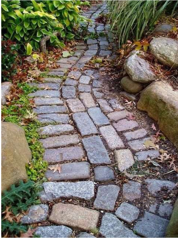
Vízáteresztő burkolat helyi építőanyagok felhasználásával
