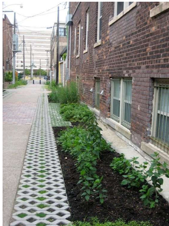
Különböző burkolatok vízáteresztő képességének jó kihasználása
