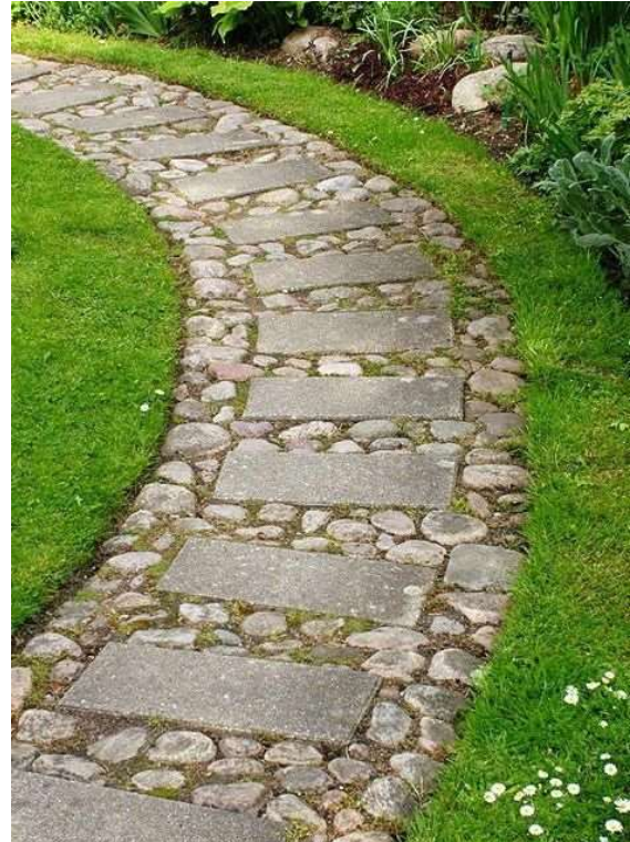
Vízáteresztő burkolat helyi építőanyagok felhasználásával
