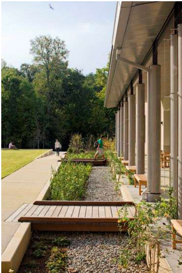
Süllyesztett zöldsáv esőkertként is megállja a helyét
