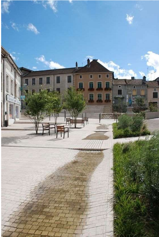
Esővíz megtartása vízáteresztő burkolattal
