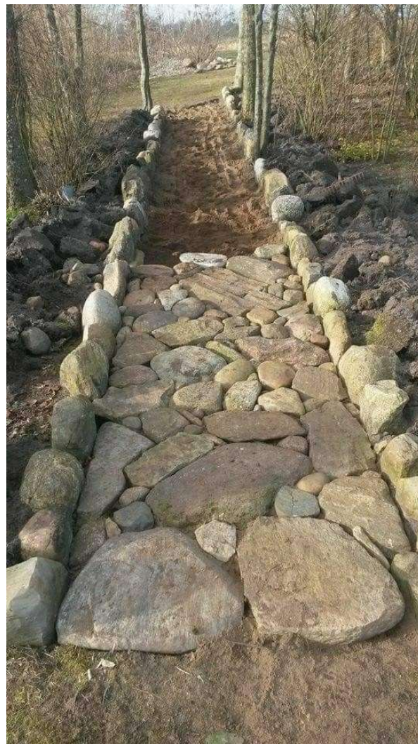
Vízáteresztő burkolat helyi építőanyagok felhasználásával
