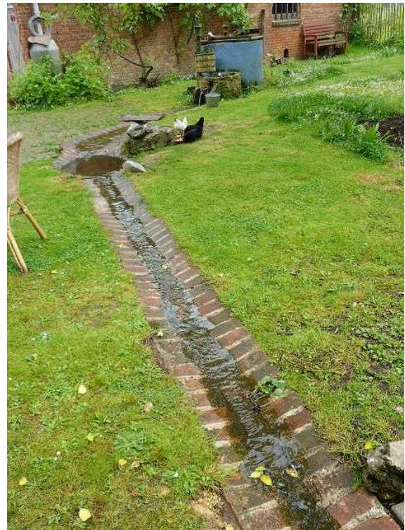
Esővíz terelése az elszikkasztó zöldfelületig
