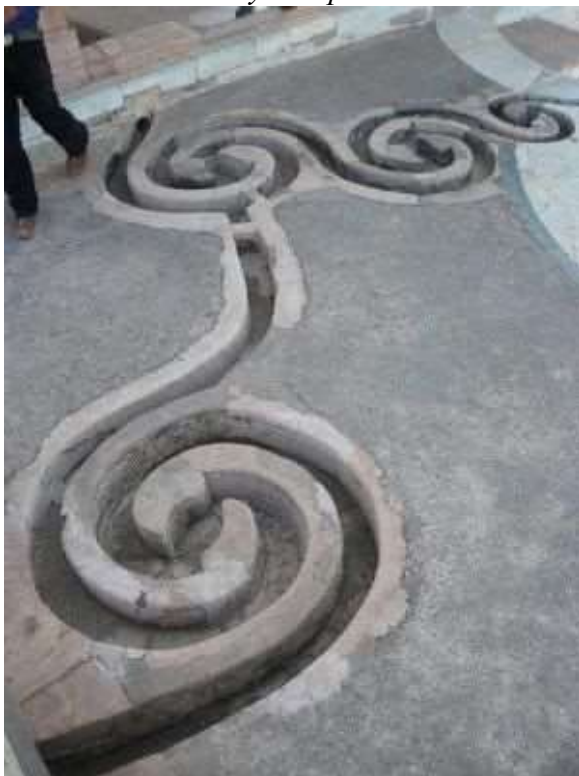
Esővíz terelése az elszikkasztó zöldfelületig
