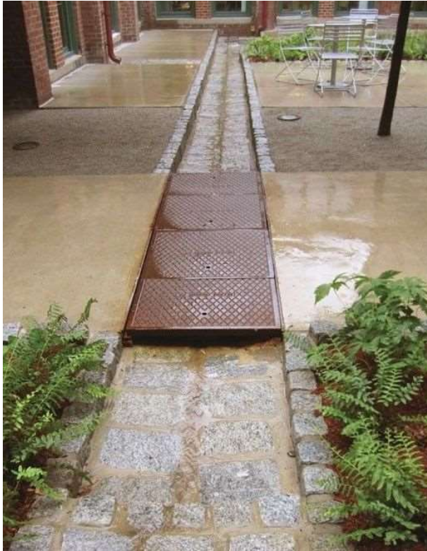
Esővíz terelése az elszikkasztó zöldfelületig
