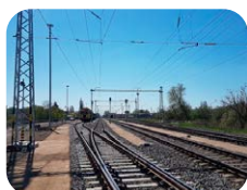
Felsővezeték (vasút, villamos, trolis)
