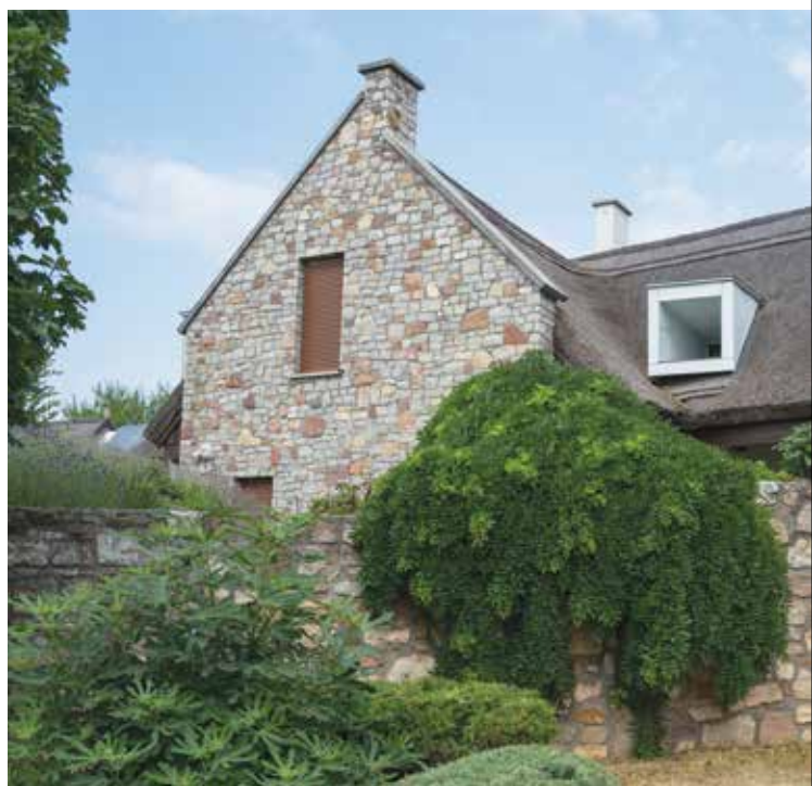
120. Vegyes terméskő homlokzat
